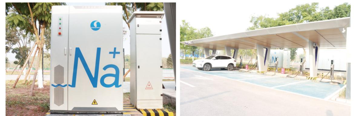
2023年底，公司500kW/1MWh光储充一体化示范项目一期工程50kW/105kWh正式在自贡投运。是四川省首个成功投运的钠电储能示范项目。
